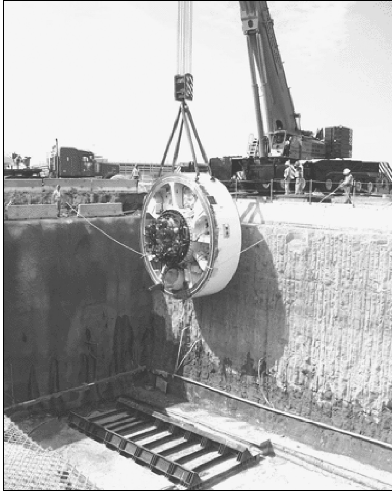
Fig. 3. Perforarea unui tunel.
